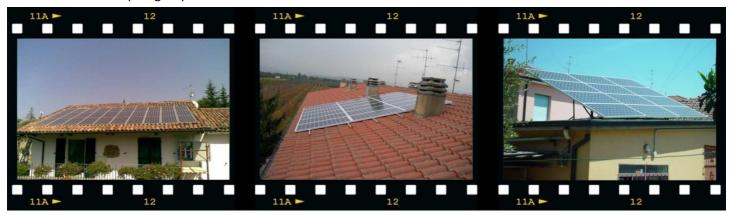
**Impianto fotovoltaico Integrato:** è un impianto fotovoltaico i cui pannelli sono completamente integrati in elementi di arredo urbano e viario, superfici esterne degli involucri di edifici, fabbricati, strutture edilizie di qualsiasi funzione e destinazione secondo le tipologie indicate nella seguente tabella (Allegato 3 del DM 19 febbraio 2007):
